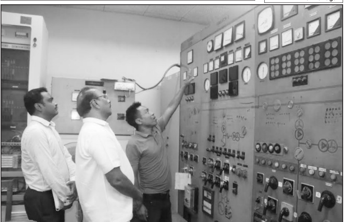
রাজপাল ইন্ড্রেনো রেড্ডি নাম্বু বুধবার ডুমুর হাইড্রো পাওয়ার প্রজেক্ট পরিদর্শন করেছেন।
